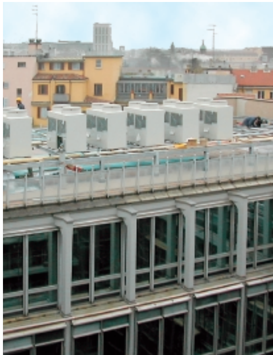
L’installazione delle unità esterne dei sistemi VRF City Multi di Mitsubishi Electric sulla copertura dell’edificio di Assolombarda nell’area tecnica dedicata.
