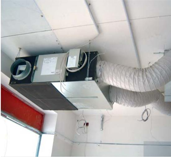
Una fase di installazione di un recuperatore di calore Lossnay in una delle filiali della Banca.
