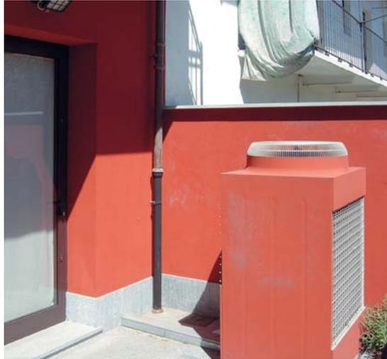
Installazione di una unità esterna del sistema VRF in una delle filiali.
