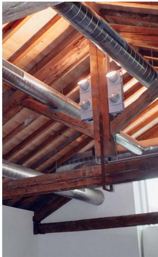
La grande sala del primo piano si caratterizza per il tetto di legno spiovente con travi a vista. I condotti di distribuzione dell'aria climatizzata, di tipo circolare di lamiera zincata, corrono per l'intera lunghezza del tetto, amalgamandosi alla struttura di insieme.
