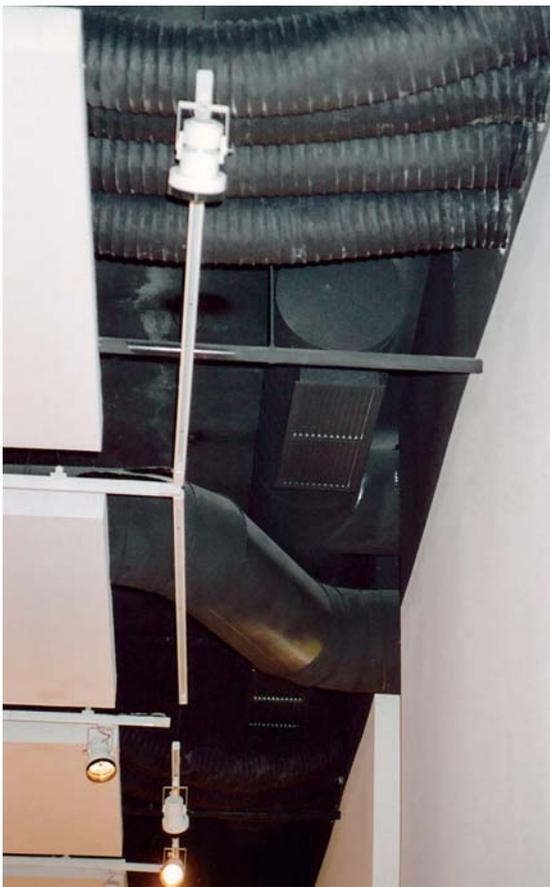
I condotti con le relative griglie di diffusione dell'aria climatizzata, al di sopra dei pannelli del controsoffitto, sono dipinti di nero, come il soffitto strutturale, per non risultare visibili dallo spazio espositivo.
